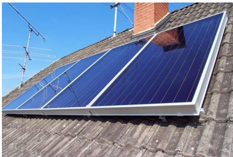
Εικόνα 1.13: Επίπεδος ηλιακός συλλέκτης σε οροφή κατοικίας
